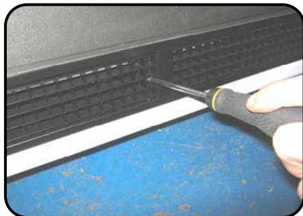
Bei den VRF HP1500DXE und VRF HP2000DXE Luftvorhängen gibt es eine zusätzliche Schraube in der Mitte des Grills, die auch entfernt werden muss.
