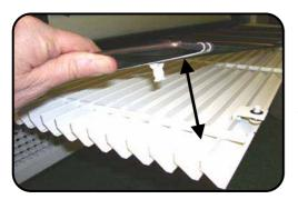
Der Lufteinlassfilter kann nun von der Oberseite des Grills gelöst und zum Abbürsten und Absaugen vom Grill entfernt werden.
