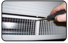
Mit geöffnetem klappbaren Auslassgrill wieder die Abhängstangen so einstellen, dass der Grillrahmen sauber an der Decke anliegt. Der Grillrahmen muss fest an der Decke anliegen und es dürfen an keiner Stelle Lücken zwischen Decke und Rahmen vorhanden sein.
