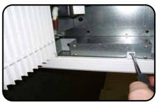
Bei HP1500R und HP2000R Geräten gibt es zwei zusätzliche Befestigungspunkte, einen in der Mitte des Geräts (wie in der Abbildung gezeigt),
