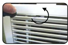
Stellen Sie sicher, dass der Grill richtig herum eingebaut wird, sodass sich der zellförmige Auslass am nächsten zur Türöffnung befindet. Den Einbaugrill in den Deckenausschnitt einsetzen und unten am Gehäuse des Luftvorhangs mit Hilfe der mitgelieferten Nr. 8 Pozi-Schrauben befestigen. Beginnen Sie mit den im Bild gezeigten Schrauben und setzen Sie dann die beiden an beiden Enden des Auslassgrills ein.
