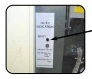
Nach erfolgter Wartung die Filteranzeige durch Drücken des Rücksetzknopfes für mindestens 5 Sekunden zurücksetzen (selbst wenn die Filteranzeige nicht rot blinkt) und die Anlage wieder an den Endnutzer übergeben.
