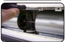
und einen in der Mitte des Auslassgrills, siehe Bild (Zugang zu dieser Schraube wird vereinfacht, wenn der ausgeklappte Einlassgrill temporär geschlossen wird).
