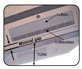
Stellen Sie sicher, dass in der Deckenaussparung oberhalb des Gerätes genügend Platz ist, die Lötarbeiten an der Verrohrung durchzuführen.
