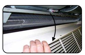
Die Vorderkante der Kondensatwanne klappt nun nach unten und die innere Oberfläche kann so gereinigt werden. Alle Fremdstoffe und Ablagerungen von der Heizschlange, der Auffangwanne, dem Auslassrohr, dem Kondensatschlauch und dem Kondensatabfuhrsystem entfernen.
