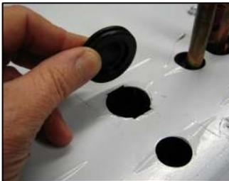
Entfernen Sie die Gummidichtung oben auf dem Gerät und führen Sie das Kabel der Transformator-Geschwindigkeitsregelung in den Luftschleier ein.
