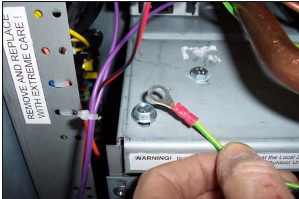
Das Erdungskabel unter der M6 Schraube im Luftschleier anschließen.
