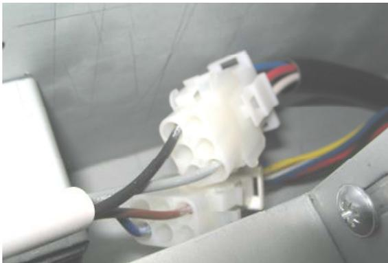
Verbinden Sie den/die 6-Weg-Stecker von der Transformator-Geschwindigkeitsregelung mit dem/den Stiftstecker(n) im Luftvorhang. Einen bei 1m und 1,5m Geräten. Zwei bei 2m Luftschleiern. Bei 1m und 1,5m Geräten bleibt jeweils eine 6-Weg-Buchse von der Transformator-Geschwindigkeitsregelung frei - dies ist in Ordnung.
