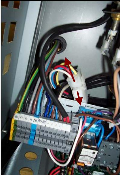
Den/die 6-Weg-Verbindungsstecker, der/die den Ventilator des Luftschleiers mit Spannung versorgen, trennen. Bei 1m und 1,5m Luftschleiern ist dies ein Paar und bei 2m Luftschleiern sind dies zwei Paare. Stellen Sie bei 2m Geräten sicher, dass beide Paare getrennt wurden.
